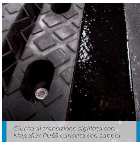
Mapeflex PU65 polimerizzato, pronto per il transito
