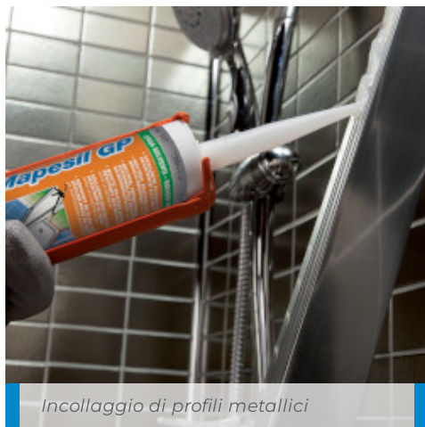
Sigillatura di raccordo tra materiali differenti
