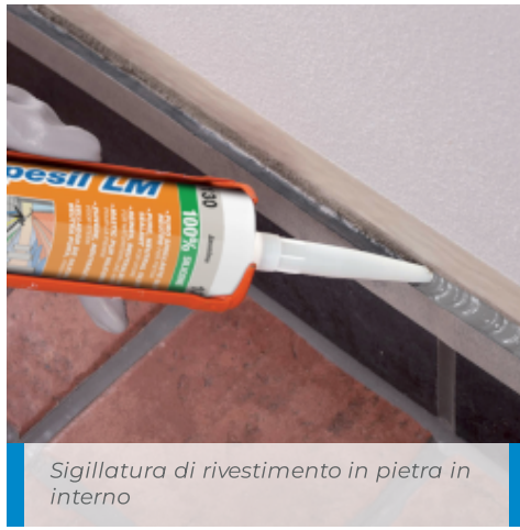
Sigillatura di giunto in facciata con Mapesil LM
