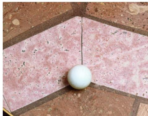
Pavimento di cotto levigato in opera fugato con **Keracolor GG** impastato con **Fugolastic**
