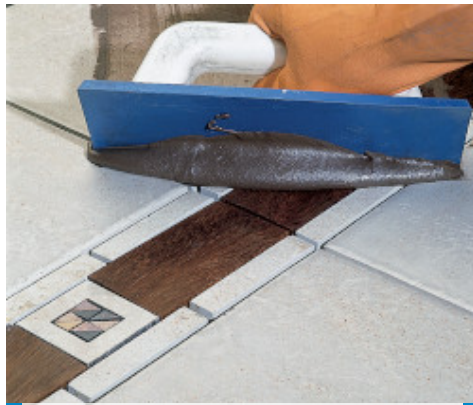
Stuccatura, con spatola, di pavimento ceramico con inserti in legno
