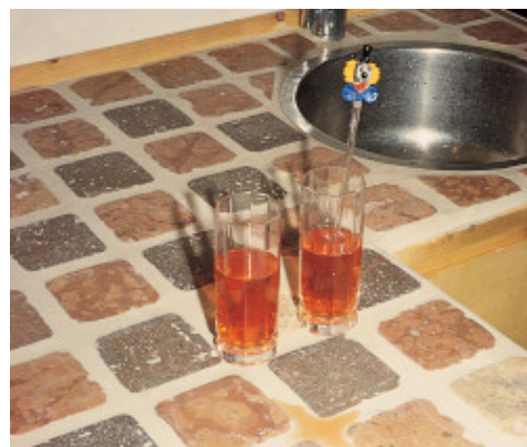
Esempio di incollaggio e stuccatura di piano di cucina
