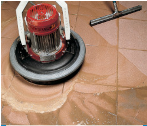
Finitura di pavimento in porcellanato con monospazzola e racla
