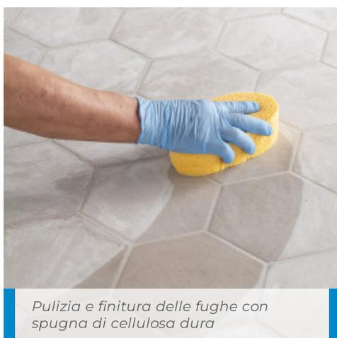
Pulizia e finitura delle fughe con spugna di cellulosa dura
