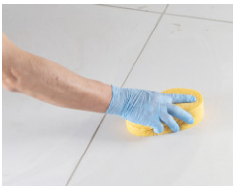
Pulizia e finitura delle fughe con spugna di cellulosa dura
