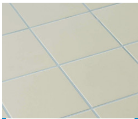
Pavimentazione finale stuccata con Kerapoxy CQ
