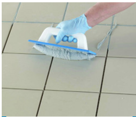
Stesura di Kerapoxy CQ con spatola di gomma MAPEI
