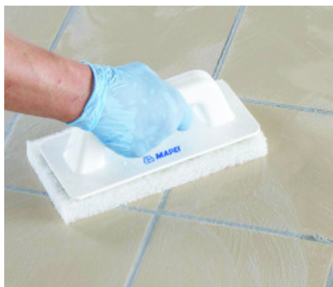
Pulizia delle fughe con Scotch-Brite®
